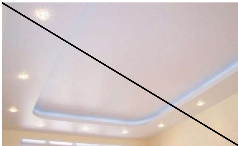
Плохо Многоуровневые гипсокартонные конструкции
